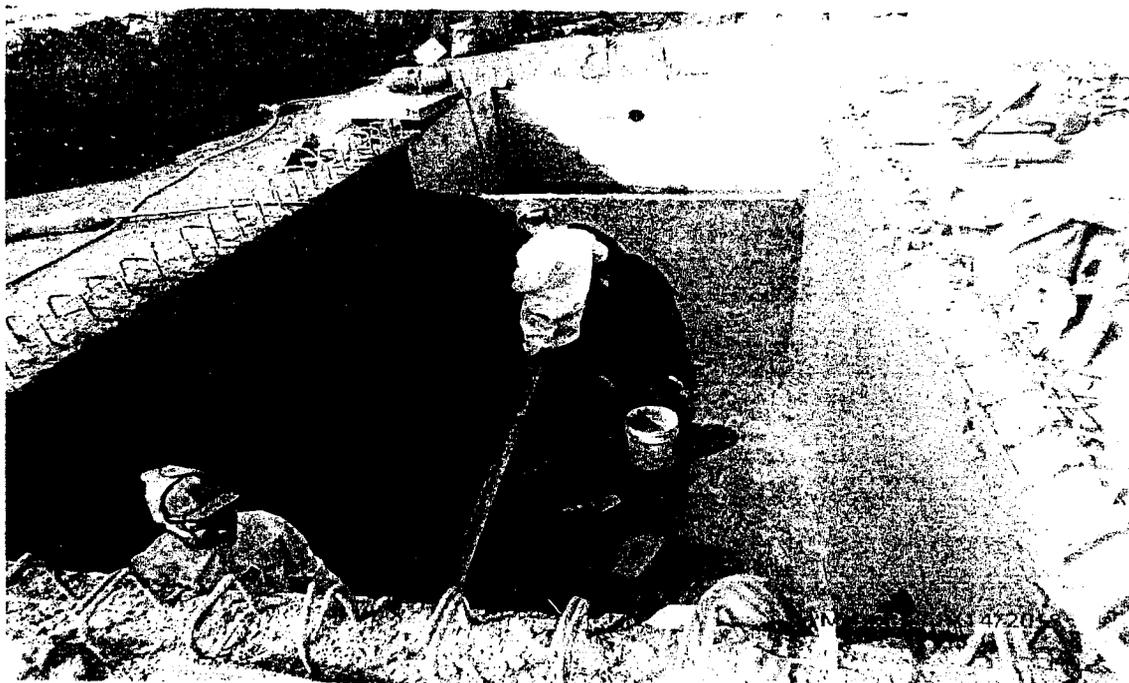
Foto N° 02: TARRAJEO CON ADITIVO INPERMEABILIZANTE EN TANQUE SEPTICO
