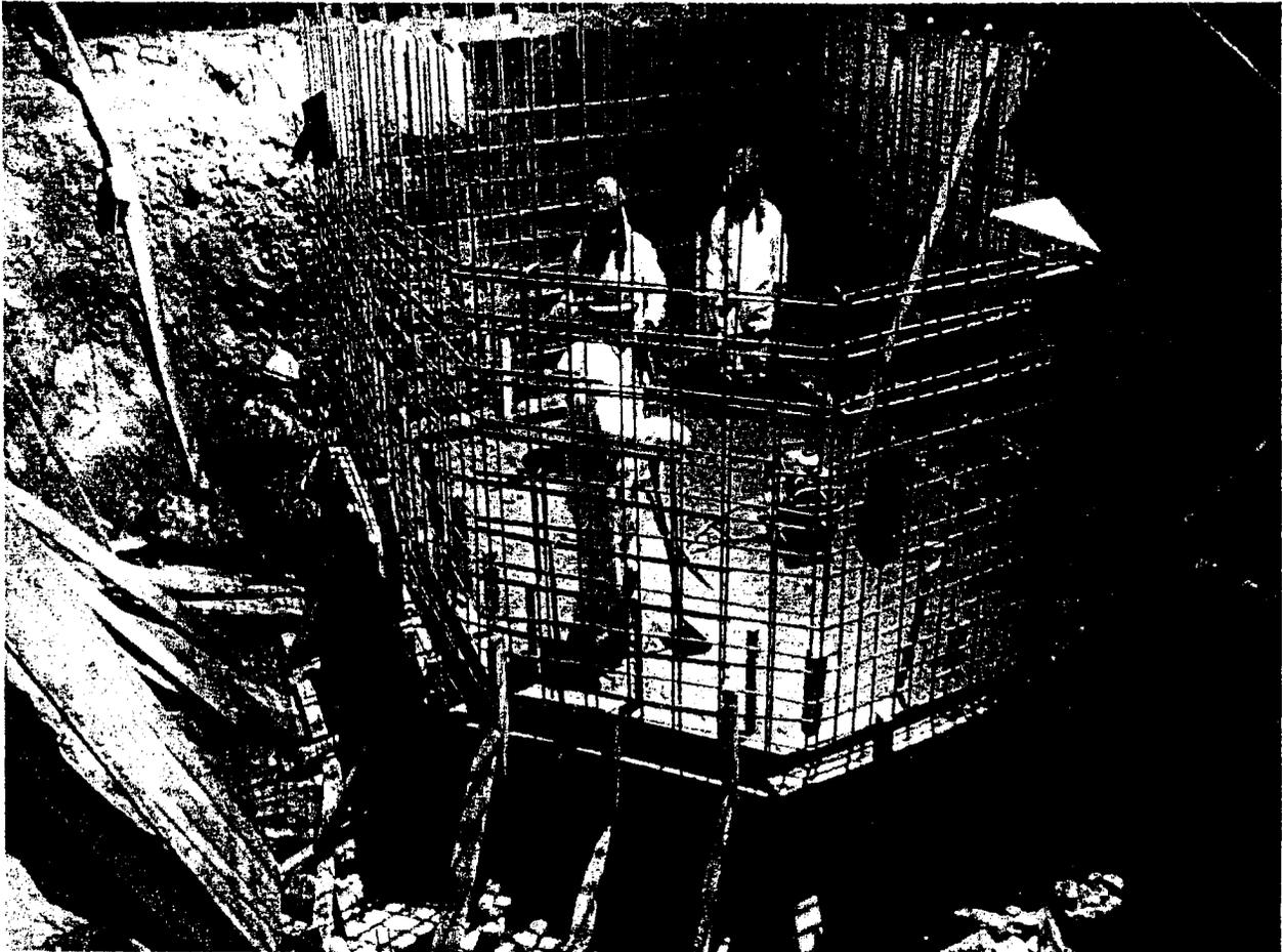
Foto N° 07: CONCRETO Y ENCOFRADO DE LOSA DE PISO EN CISTERNA DE AGUA SALADA
